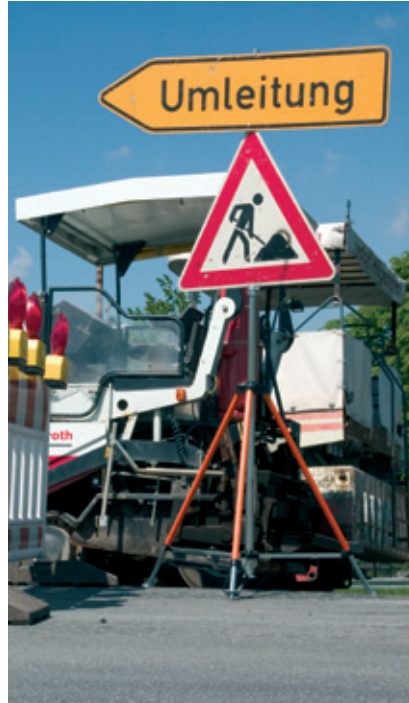
Verkehrleitsystem traffic control system
